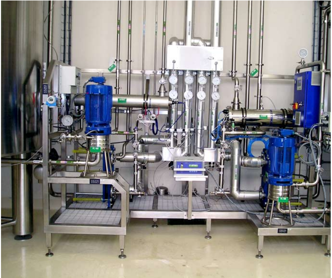
Sistema de distribuição de água purificada
