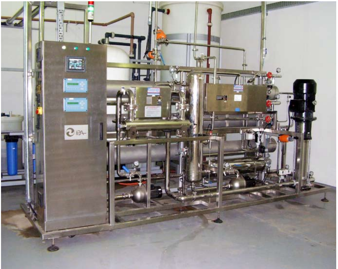
Sistema de osmose reversa de passo duplo com sanitização térmica - água PW
